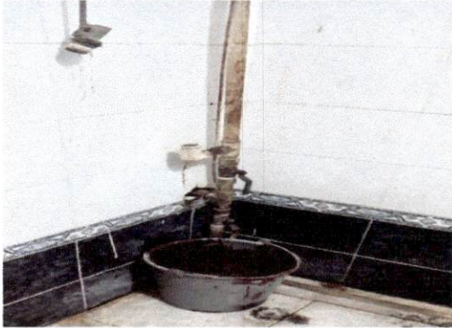
Foto 1: Servicio sanitario en mal estado
